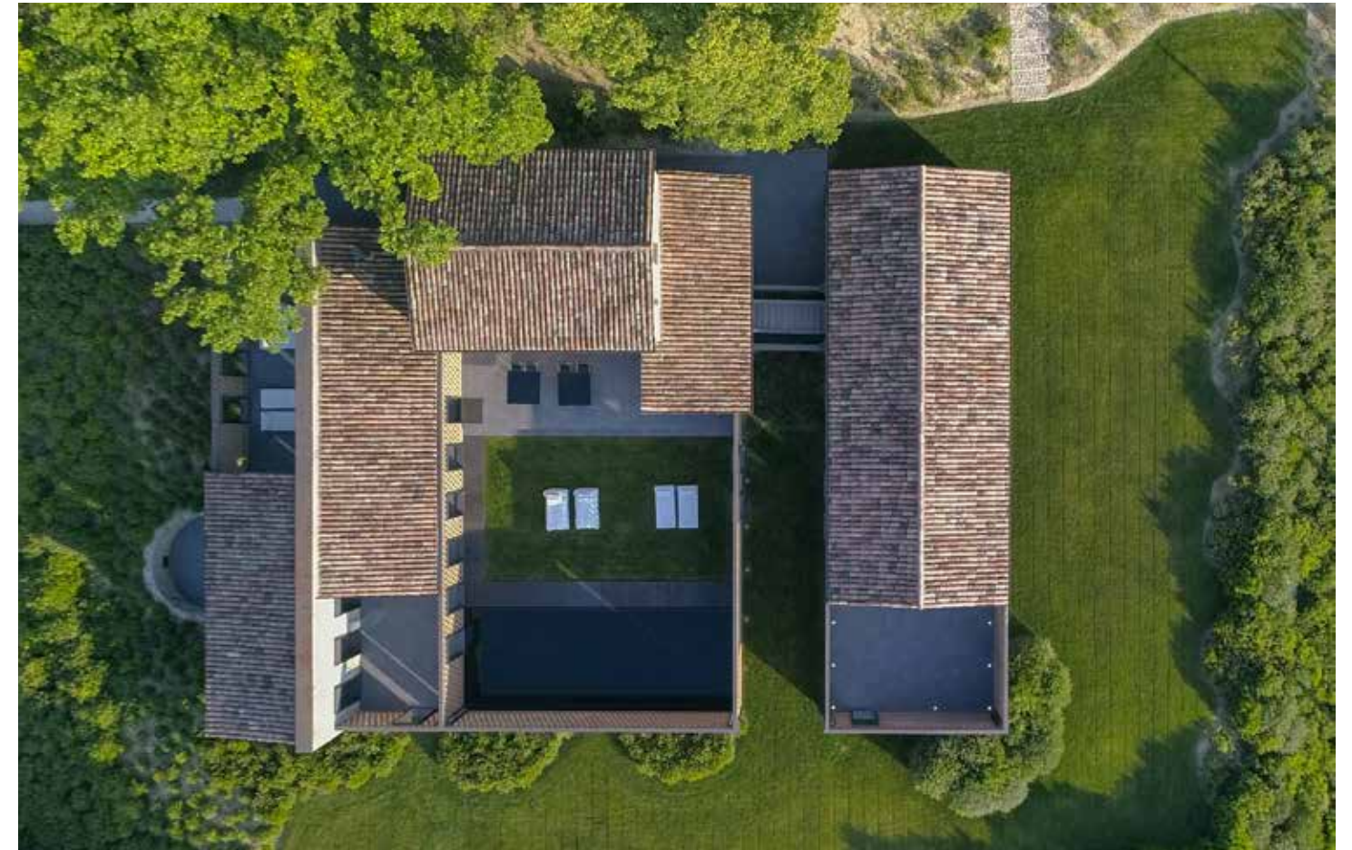
I tetti della residenza.
